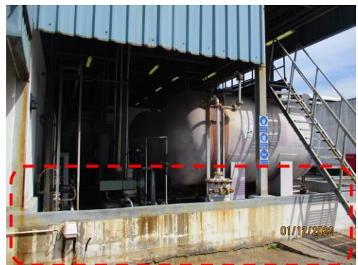
ถังบรรจุทรายดูดซับและคันกัน (Dike) สารเคมี
