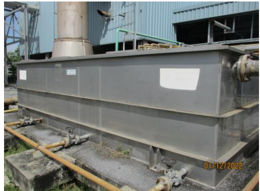
ระบบ Oil Water Separator
