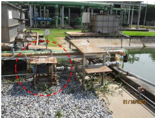
ปั๊มสูบน้ำจากบ่อพักน้ำทิ้ง Holding Pond
