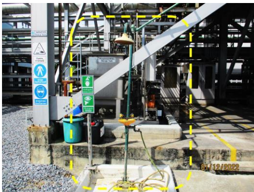
ฝักบัวชำระล้างร่างกาย และที่ล้างตา ที่ล้างมือและเท้า
